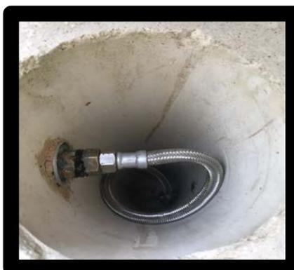
**Le robinet de la fontaine et la collerette sont à fixer avec le manchon fourni, le manchon est à fixer à l'arrivée d'eau. Il faut utiliser de la filasse ou du joint spécial raccordement pour éviter toutes les fuites d'eau et de rouille.**
